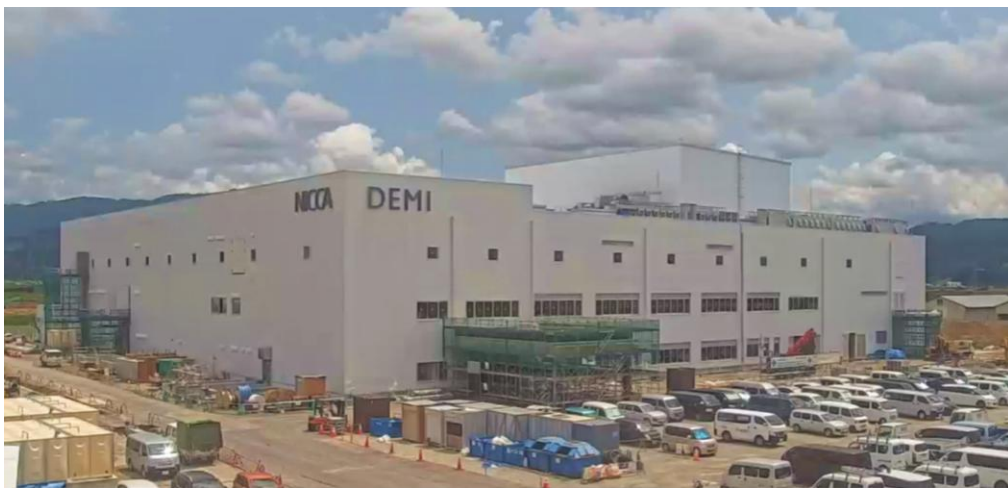
建設工事の様子(7月29日 時点)
