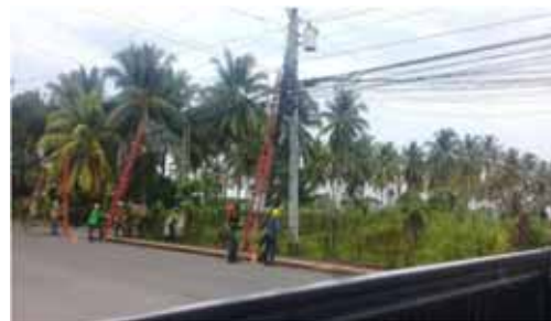
ミンダナオ ダバオ周辺での工事作業
