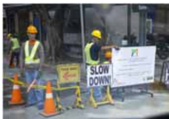
Makati市内の 回線敷設工事現場
