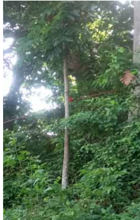
右) 電柱がなく、木に括りつけて代替している。
