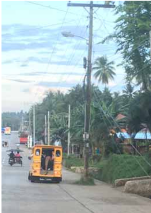
左) 通信線が、電柱から垂れており、車両の接触による切断のリスク大
