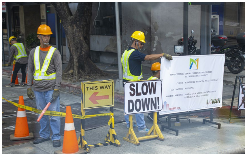
Makati市内の回線敷設工事現場
