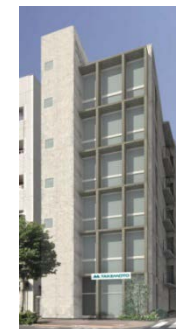
Standout ラボ(建設中)
