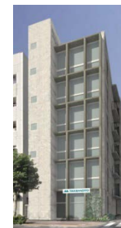
Standout ラボ (建設中)
