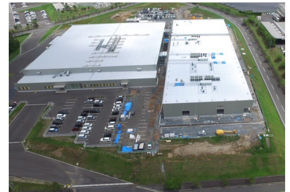
〔増設棟（右側） 工事中の岡山事業所〕
