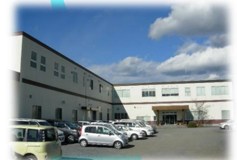
関東工場・東日本営業所
