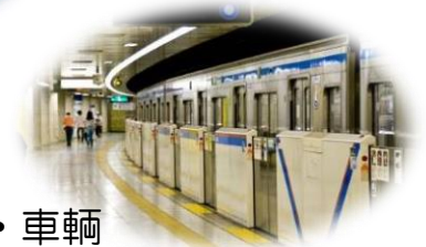
配電盤 開閉器 避雷器
