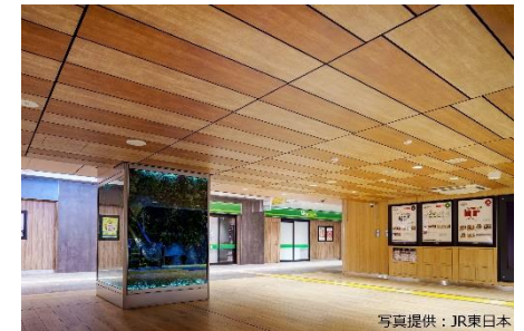
▲新工法で施工されたセラール
