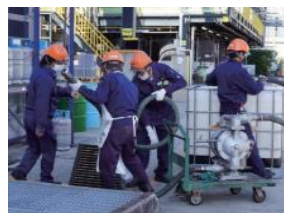
▲清掃作業の様子
