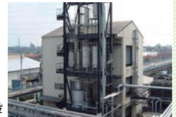
既存の高沸点溶剤精製装置に蒸留塔を1ライン増設
