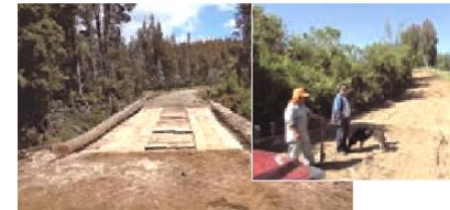
南米チリ共和国の植林地でのインフラの整備
