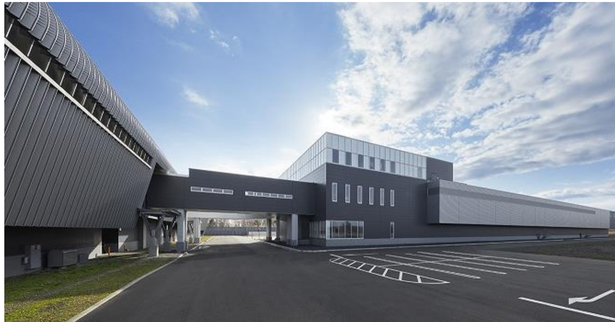
▲石狩データセンター外観（正面：3号棟、左：1・2号棟）
