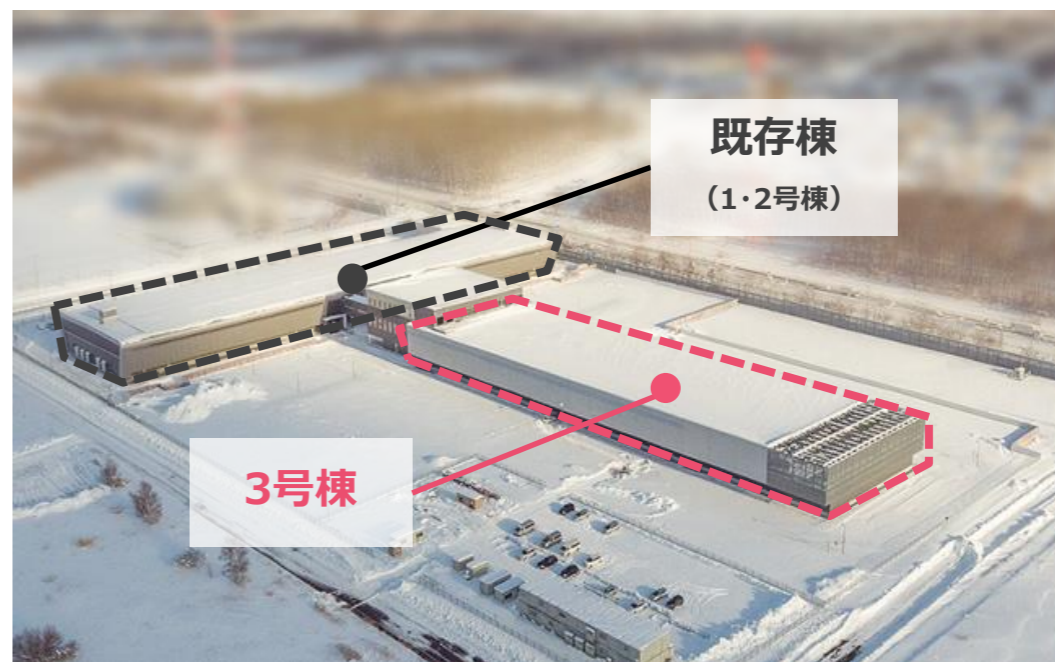
▲石狩データセンター-航空写真
