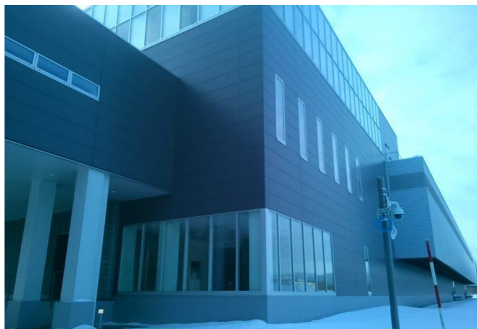
▲石狩データセンター-3号棟正面
