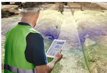
⑦ 建設測量
