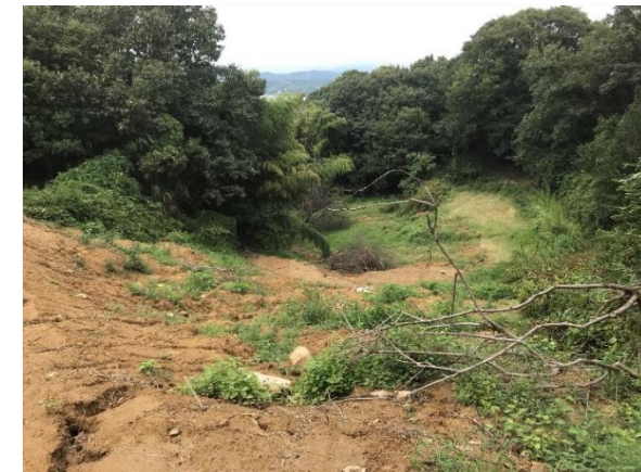
広島県神石高原町土砂現場
