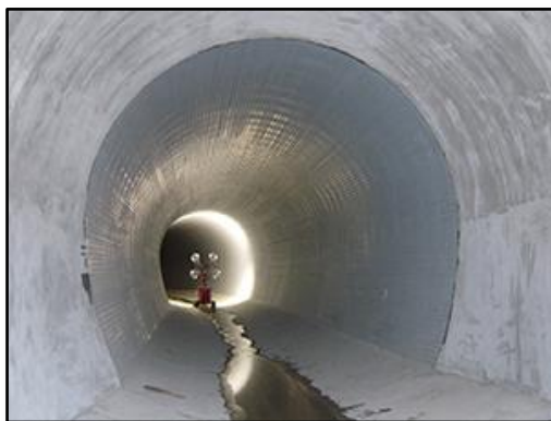
▲パルテム・フローリング工法
