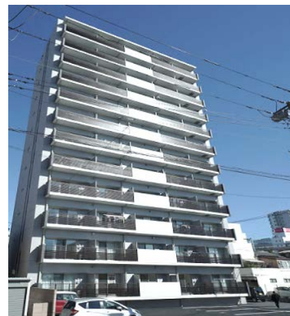
水戸市南町「レーガバーネ南町」 (18年10月完成)
