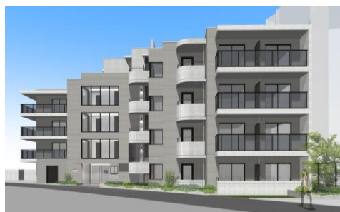
グランデュオ GranDuo 経堂15 駐車場にEV充電設備「Terra Charge」設置
