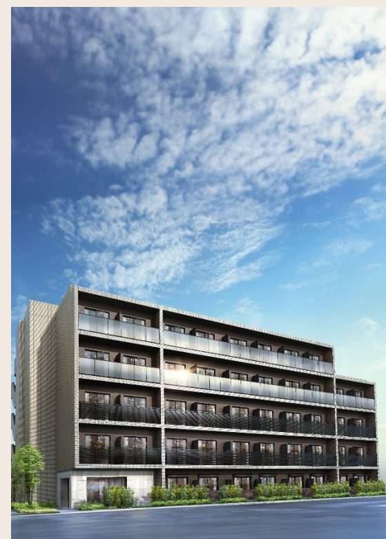
登戸新町PJ 2024年3月竣工
