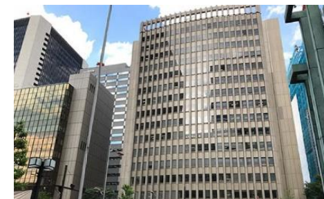
新橋カンファレンスセンター：2,813坪
