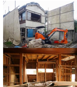
解体工事 不要物整理
