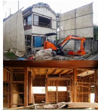
解体工事 不要物整理
