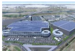
ロジスクエア京田辺A (京都府) ※写真左側 延べ面積 155,878㎡予定
