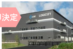
ロジシティ小郡 (福岡県) 延べ面積 28,364㎡
