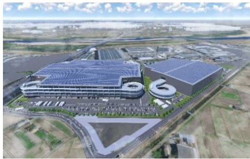
ロジスクエア京田辺A（京都府） ※写真左側 延べ面積 155,878㎡予定
