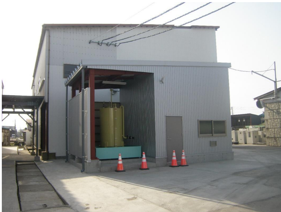
【J社（ボイラー室新築工事）】
