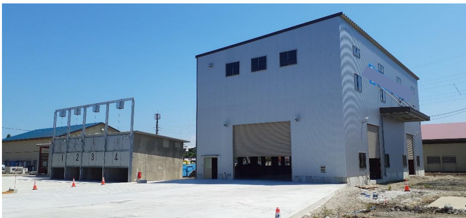
【鉄骨建築（J 社工場及び養生室、ボイラー室新築工事）】
