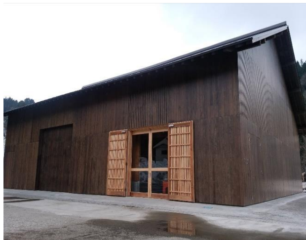
【木造建築（雪中貯蔵施設）】
