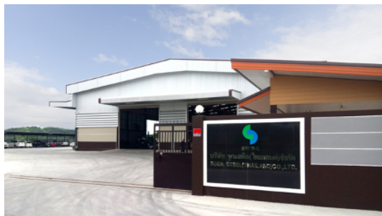
（スガスティール・タイ）工場外観
