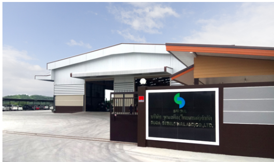
(スガスティール・タイ) 工場外観
