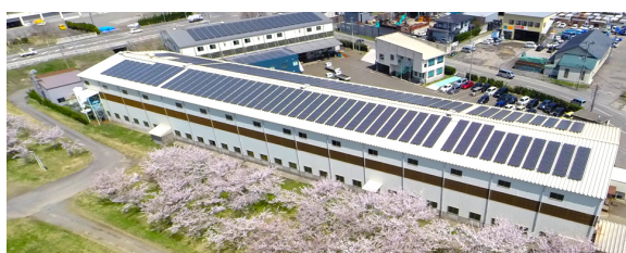
（太陽光発電事業）本社工場屋根の太陽光パネル
