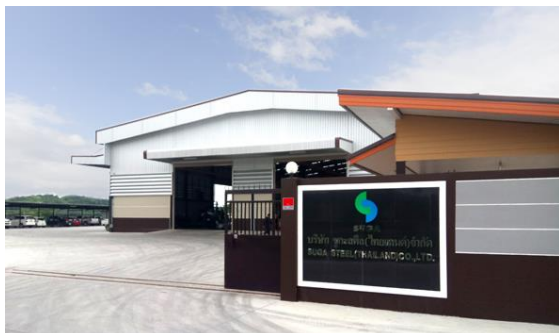
(スガスティール・タイ) 工場外観
