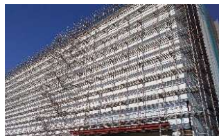
マンション工事
