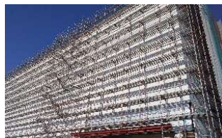
マンション工事
