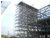
大規模倉庫 屋根成形工事
