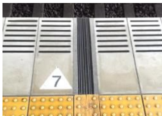
エキスパンションシール YFP 駅のプラットホーム・歩道橋等の躯体縁切り部継手
