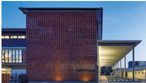
特注レンガ施工事例 (前橋市立桃井小学校)
