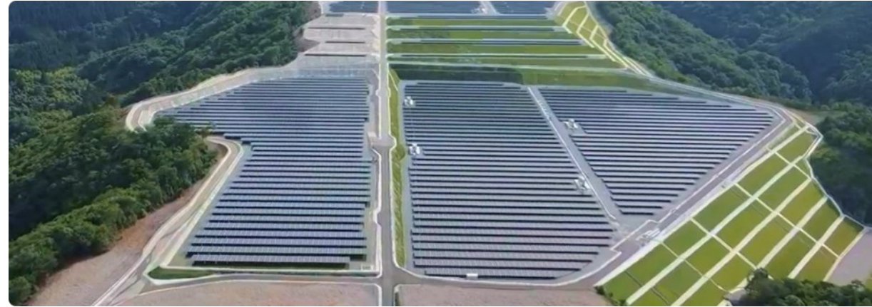
大型太陽光発電所施工事例
