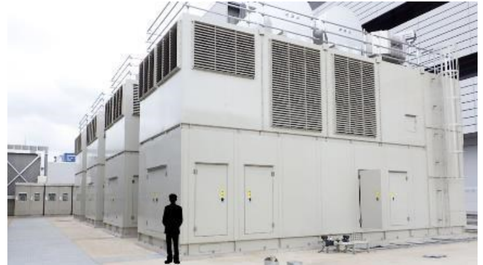
データセンター向け3900kVAクラス発電機用防音エンクロージャ
