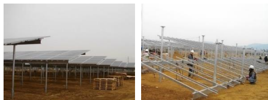
太陽電池アレイ支持架台設置工事
