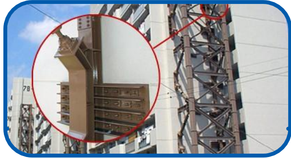
建物の耐震補強に・・
