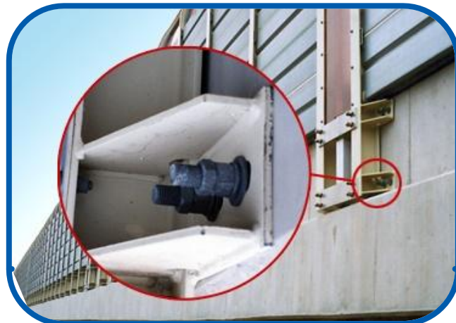
高速道路の防音壁に・・
