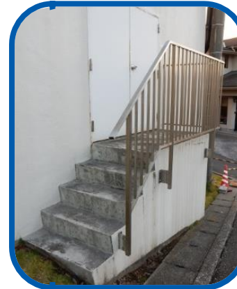
手すりの取付けに・・
