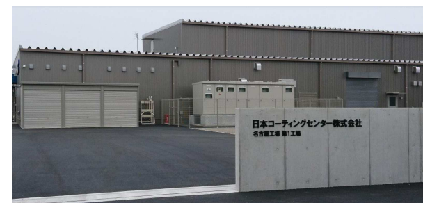
< JCC 名古屋工場 第1工場 >
