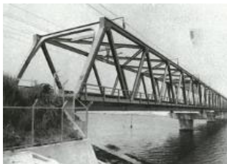
東海道新幹線江川橋梁
