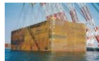
南本牧鋼製ケーソン
