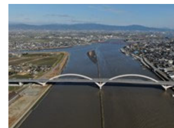
有明筑後川大橋
