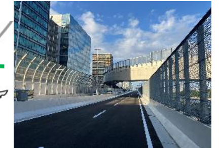
高速1号羽田線(東品川橋・鉸洲埋立部)更新工事 首都高速道路株式会社 大林・清水・三井住友・東亜・青木あすなる・川田・東骨・MMB・宮地異工種JV
