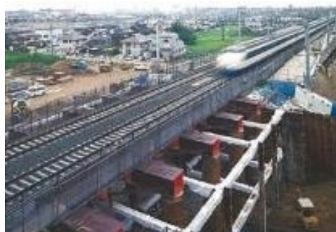
東海道新幹線箕輪架道橋
