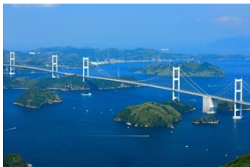
来島海峡第二大橋
