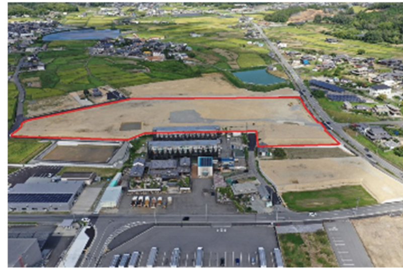
宮地エンジニアリング(株) 兵庫機材センター 造成後(写真の赤線内)
