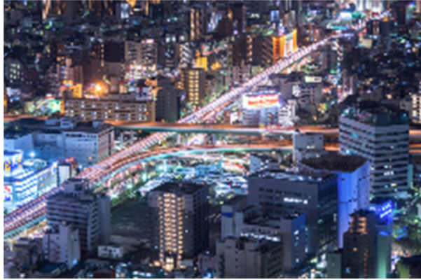
市道高速1号他新洲崎工区改築事業(工事) 大林組・大豊建設・矢作建設工業・川田工業 ・エム・エムブリッジ・宮地エンジニアリング ・瀧上工業・駒井ハルテックJV
