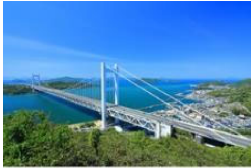
下津井瀬戸大橋
