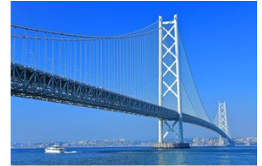
明石海峡大橋
