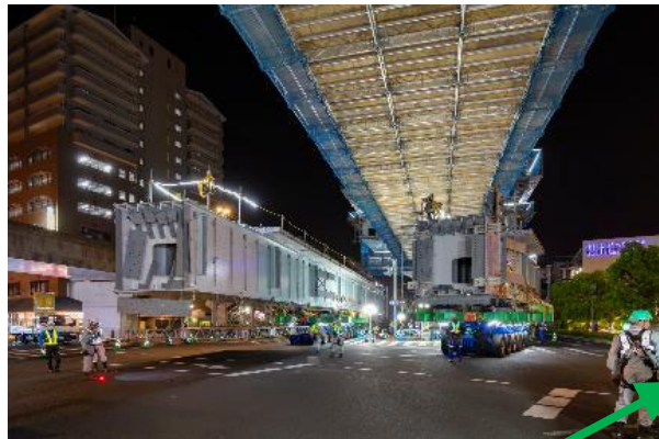
佐世保道路 佐世保高架橋(拡幅)工事 西日本高速道路株式会社 エム・エムブリッジ・瀧上工業・富士ピー・エスJV
