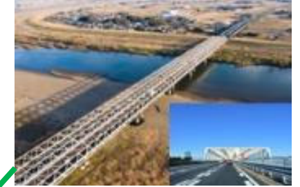
東北自動車道 利根川橋耐震補強工事 東日本高速道路株式会社 エム・エムブリッジ株式会社・鉄建建設株式会社
