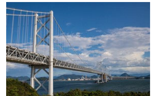
北備讃瀬戸大橋・南備讃瀬戸大橋
