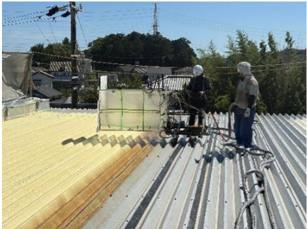
SOSEIラインロボの施工風景と表面品質
