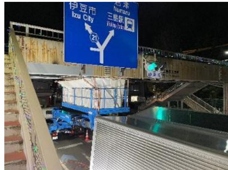
CoolLaserによる歩道橋メンテナンスの様子
