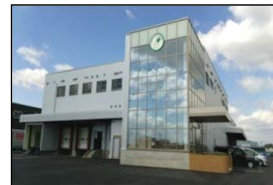
奈良FSセンター（2015年竣工）
