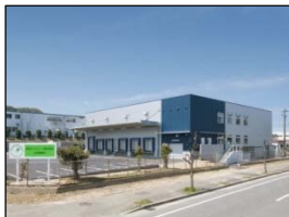
九州事業所（2012年竣工）
