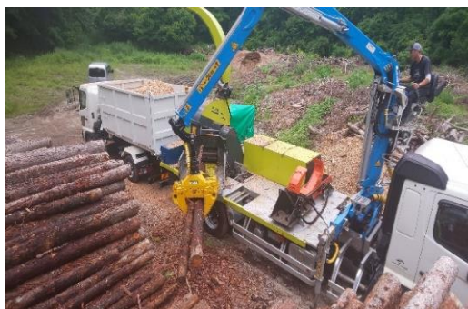
＜バイオマスボイラー木質チップ製造状況＞
