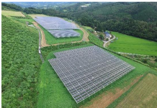
〈一関市吉高太陽光発電所〉
