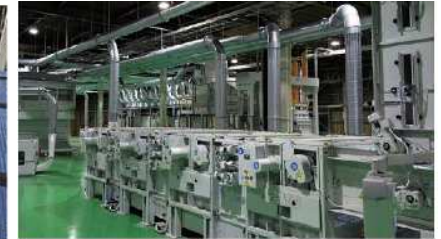
古着反毛リサイクル設備
