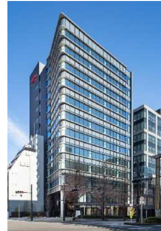
八重洲通フィルテラス
