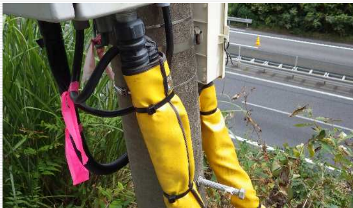
通信ケーブルの保護カバーとして使用される「P-TEX」
