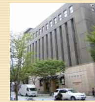
ニッケ神戸本店ビル （兵庫県神戸市）
