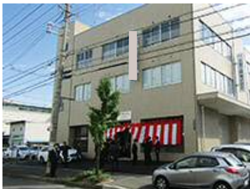
テクニカルセンター 外観
