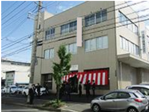
テクニカルセンター 外観
