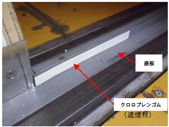
大扉開放（ゴムあり）
