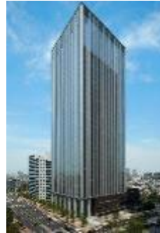
新宿フロントタワートランクルーム (東京都) 既存ビルの2階フロアを改装
