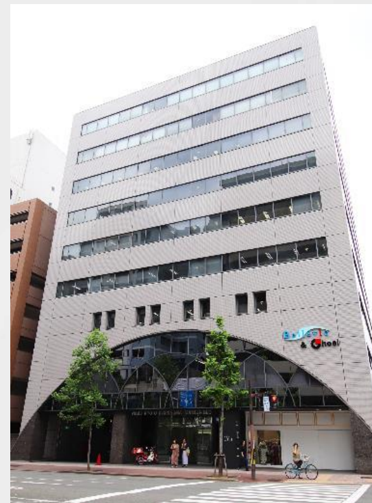
本社 (No.60京都烏丸万寿寺ビル)
