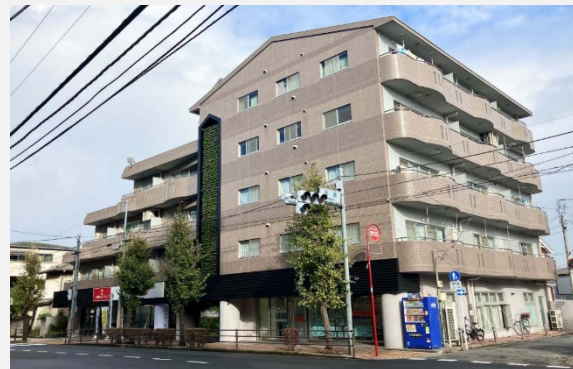
▲U residence 三鷹。修繕に耐久性の高い素材を利用し、今後建物のメンテナンス費用を抑えられることが期待される。
